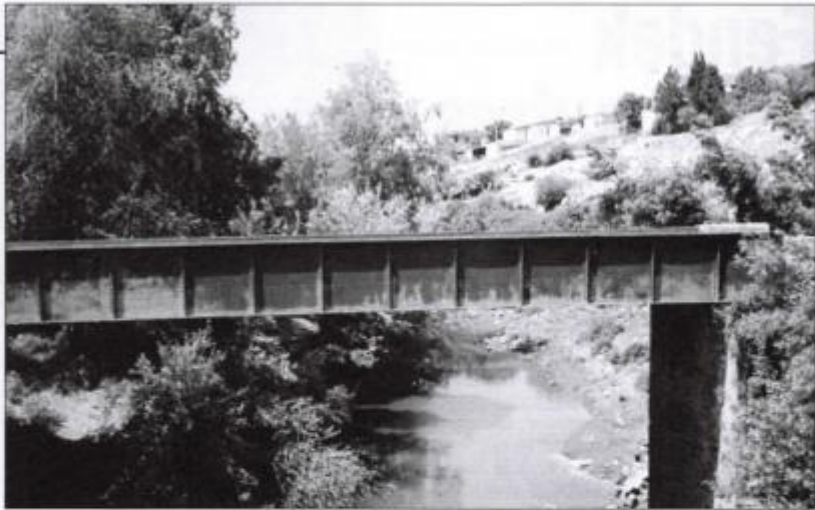
Ci-dessus, le vieux pont métallique de Lannoy. En bas à gauche, Gaston Brandi sur une rive de l'oued Fendek, lors d'un voyage en 1983. A droite, le pont de bois vers la Zaouïa.
