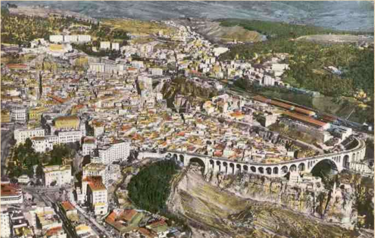
Le Pont Sidi Rached et vue sur la Ville - CP
