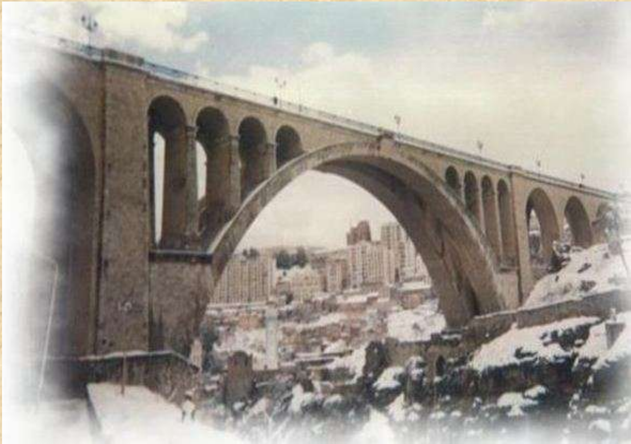
Arche du Pont Sidi Rached-ville sous la neige-
