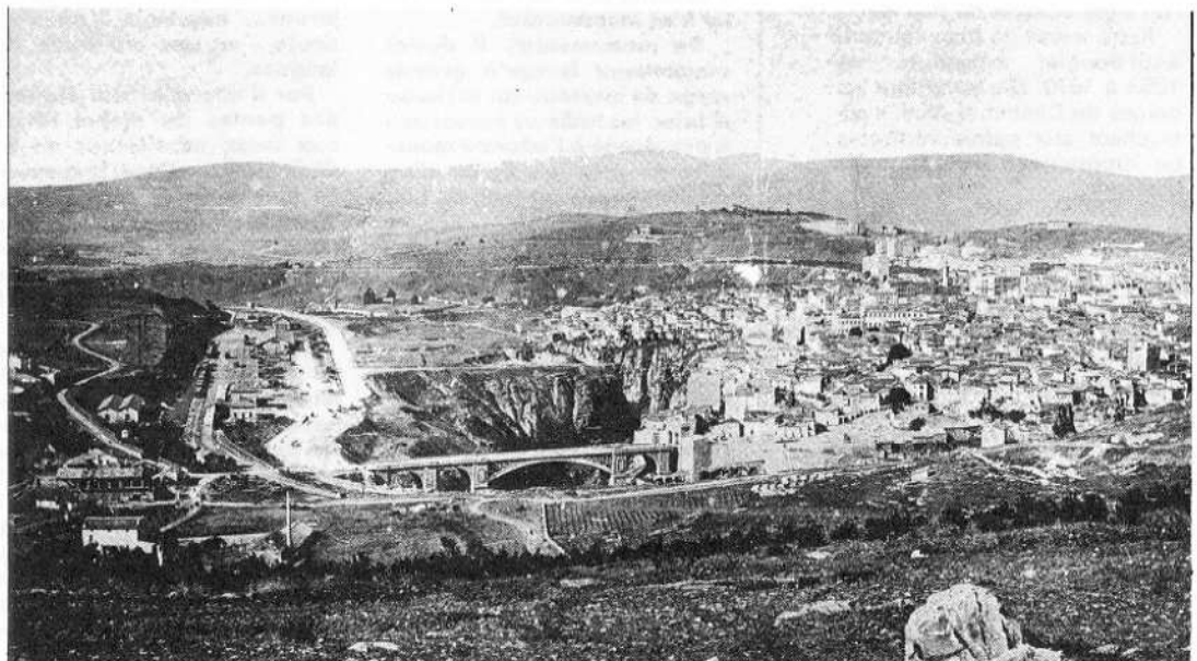
Le site du pont d'El Kantara au moment des travaux
